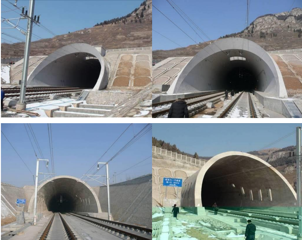
图 5.4-1 京沪高速铁路正线隧道洞口缓冲结构图
